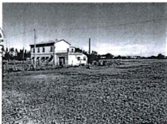
Vista fabbricato e terreno in direzione nord
